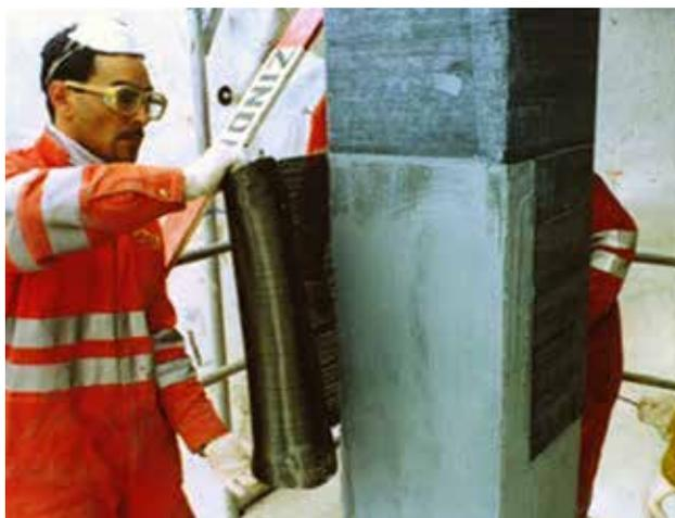
**Aplicação úmida:** instalação de tecidos pré-impregnados mais pesados do que 450 g/m<sup>2</sup>
