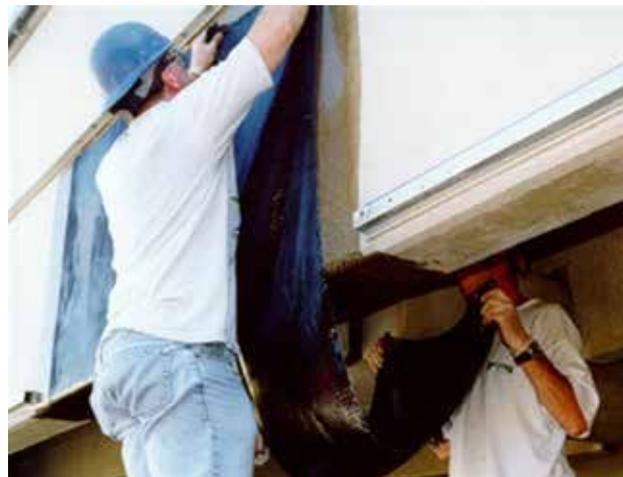
Sistema de reforço estrutural e adaptação sísmica com polímero reforçado com fibra SikaWrap®:
